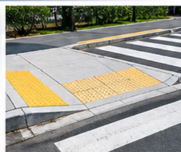
Rebaixamento de guia
